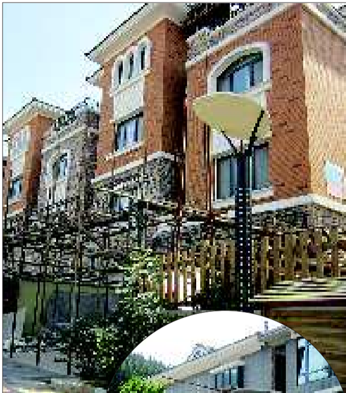
▲一别墅前搭起了脚手架,正准备盖车库。
