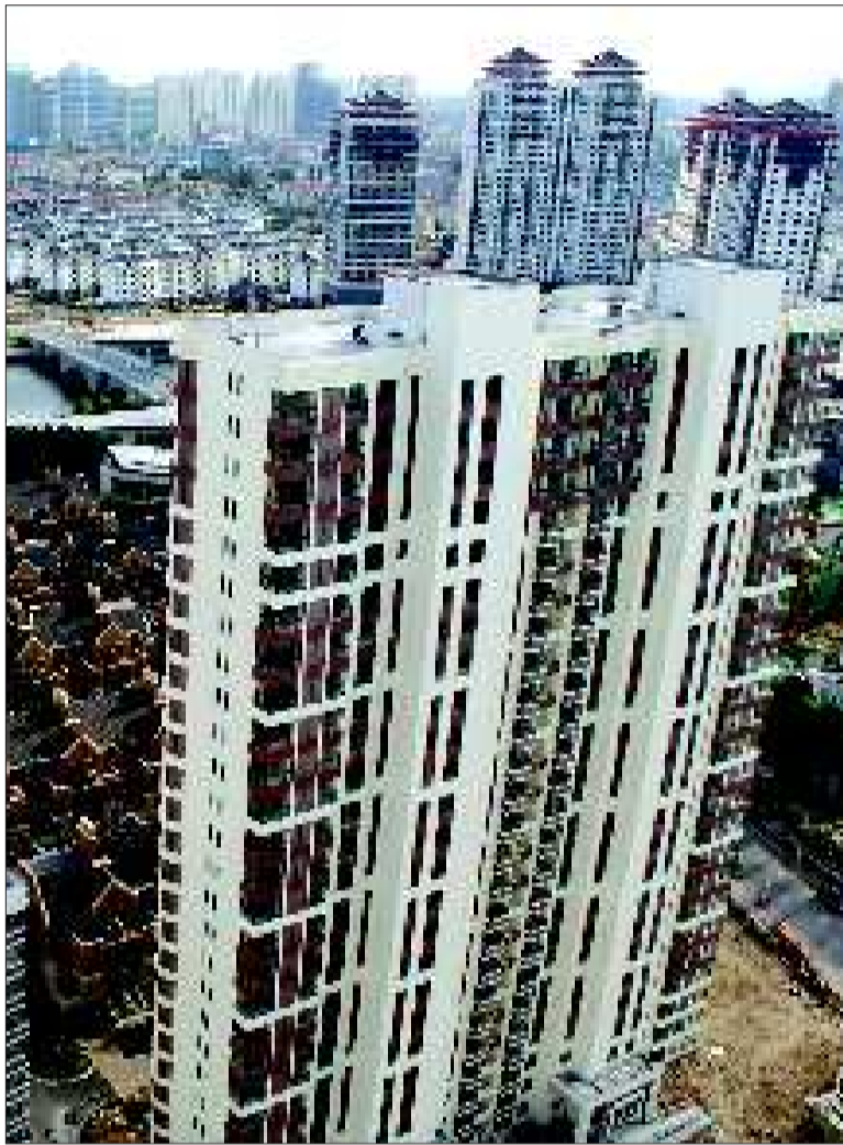
▲楼房越来越高，抗震性能越来越受关注。
