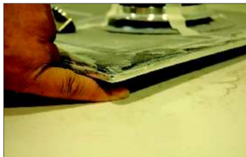
▲厨房内,灶具的安装很不牢固。
