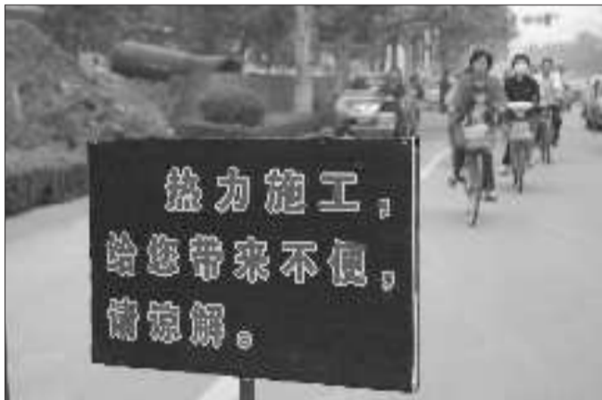
今年,城区实施了徒骇河东西两个区域热源替代工程。图为徒骇河以西热源替代工程兴华路施工现场。目前,该工程已接近尾声。(本报资料片)
