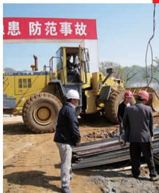
沙窝村改造过程中,工人们正在施工。(环翠区供图)
