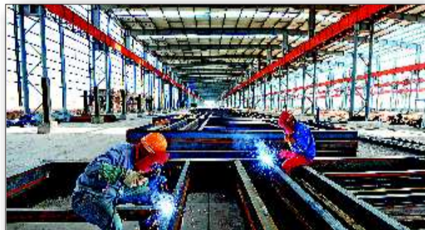
▲位于中宁县新材料循环经济工业园区的万隆稀土彩钢公司,技术工人正在焊接彩钢着色平台。(苏保伟 摄)
