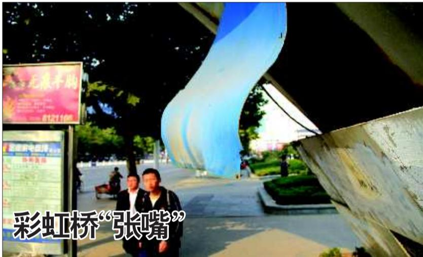
10月31日,在沂蒙路南段,一彩虹桥东段底部的部分铁皮破坏严重,高高“翘起”,伸向人行道上方,随时都有可能脱落,砸伤路人,存在很大的安全隐患。 记者 徐升 摄
