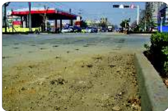
路口的洸河路路面已被破拆, 即将开挖。
