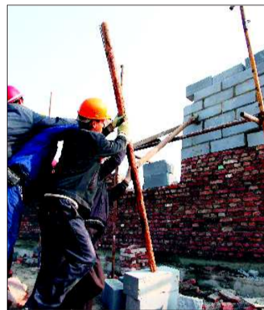
众人合力拆除一处正在建设的违规建筑。(本报记者 赵金阳 王鸿光 摄)
