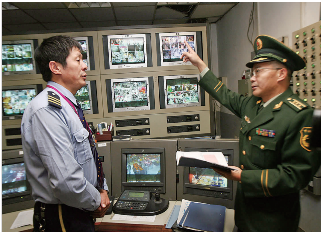
在佳世客监控室,工作人员被抽查应对紧急情况的处理方法。 本报记者 杨宁 摄
