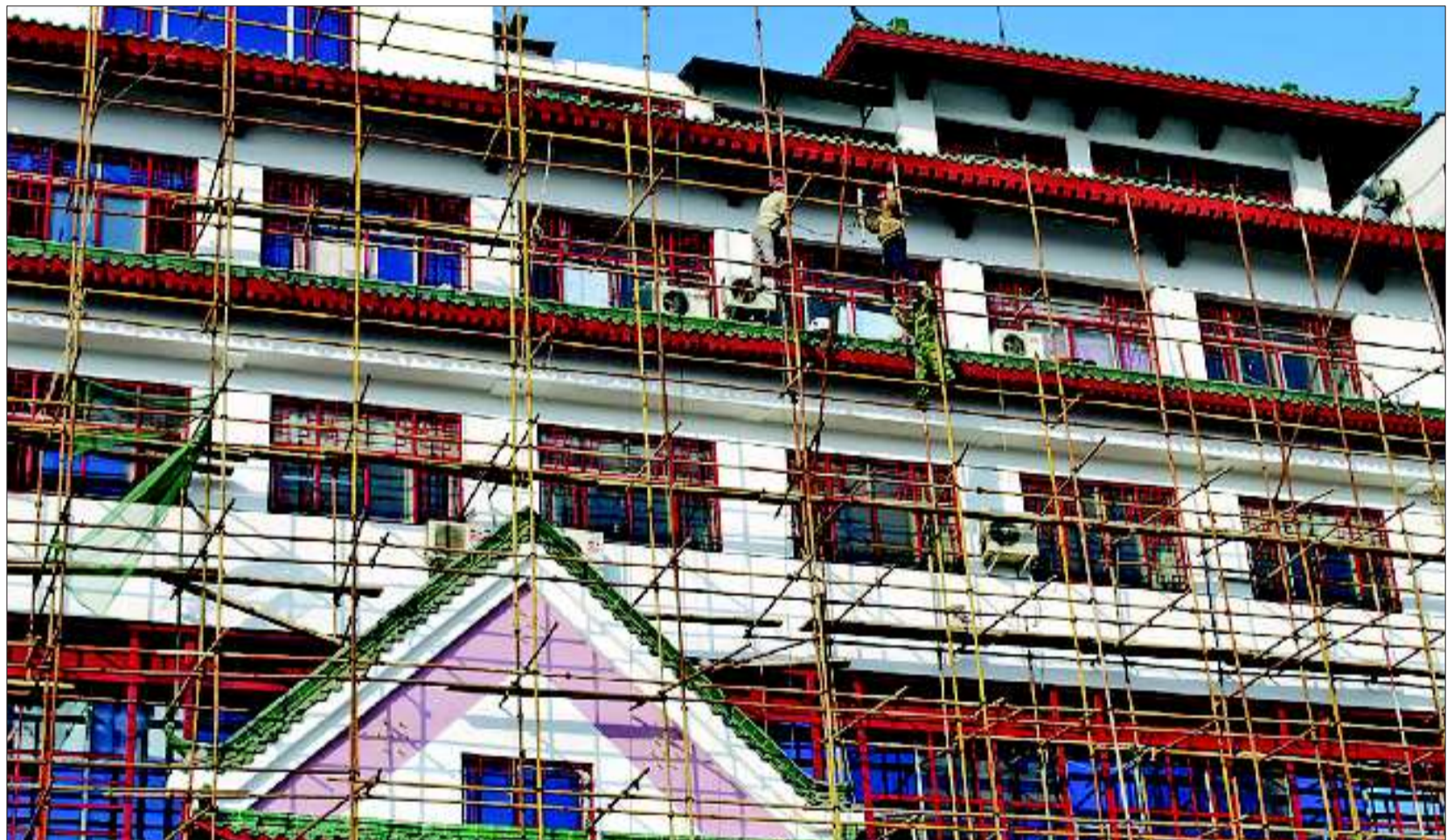
▲华夏商厦立面改造已基本完工,工人正在拆除脚手架。 本报记者 刘守善 摄
