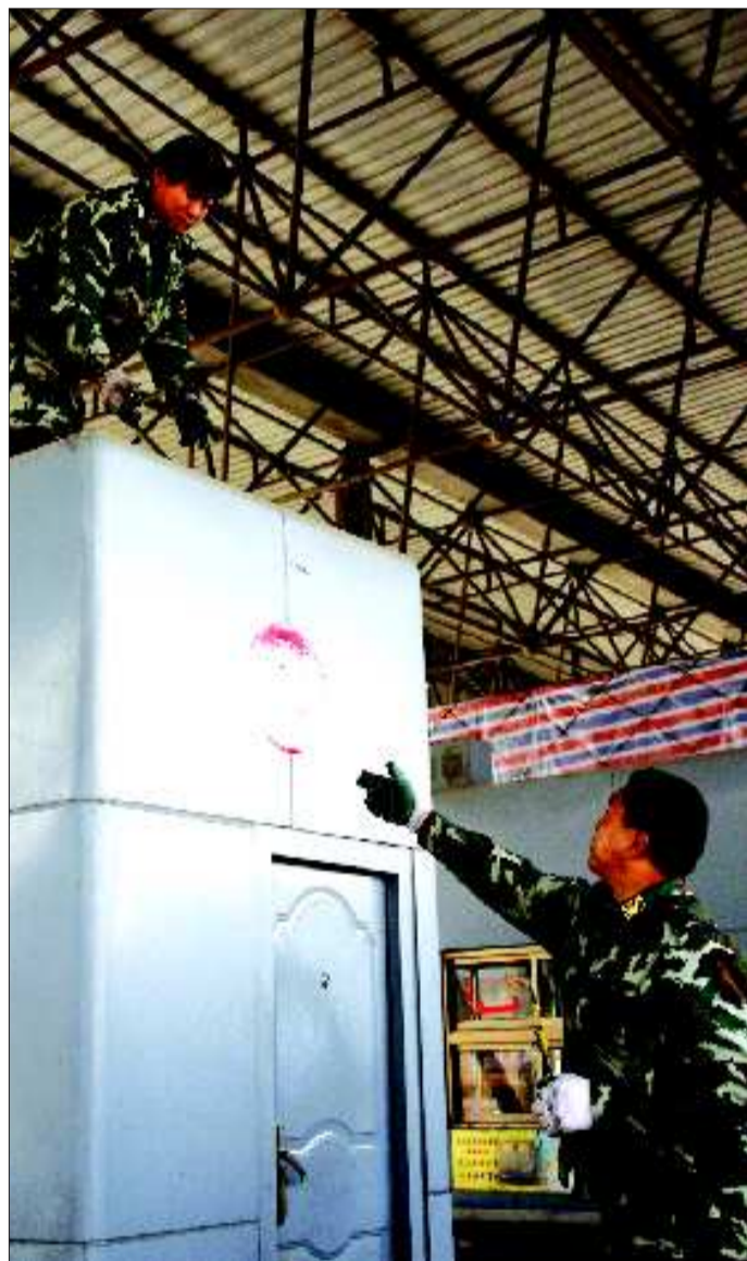
工作人员进行站内设备拆除。
