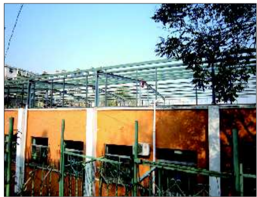
幼儿园快建好的钢架“楼上楼”。 记者 冯荣达 见习记者 毛旭松 摄
