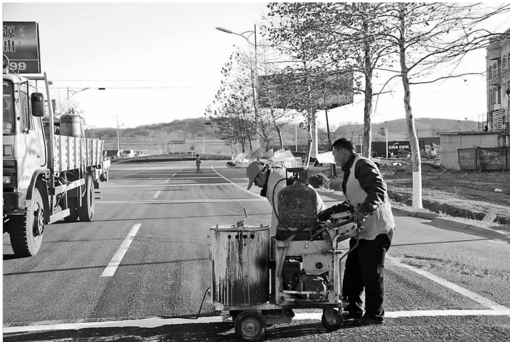
大水泊环岛位于国道荣兰线和省道威石线交会处,来往车辆较多,震荡减速标线磨损严重。为改善此路段交通安全状况,近日,文登市公路局在驶向环岛的四个方向上,重设了共计1311米长的车行道横向震荡减速标线。 本报记者 周艳利 本报通讯员 蔡进明 摄影报道
