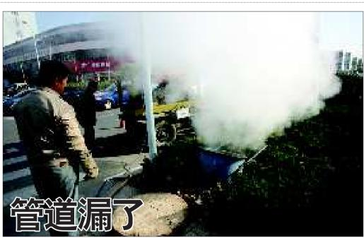
7日,在潍坊市健康街与虞河路路口,热力公司的工作人员正在对一处冒热气的窨井进行检查。据了解, 当天处在路口安全岛上的井口冒出大量的蒸汽,热力公司的工作人员带来了排气扇将井中的热气排走,然后下 井查看。工作人员介绍,由于白天管道压力大,如果维修需要等到晚上管道内的压力变小后才能维修
