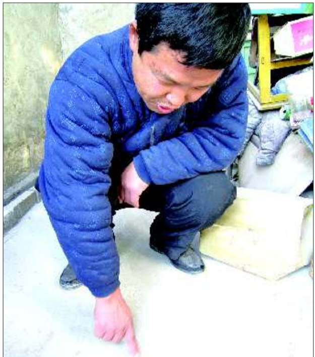
王先生家中的水泥地面,用脚一搓水泥粉末和沙子就掉了下来。
