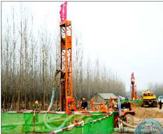
施工现场。本报通讯员 宋志凌 摄
