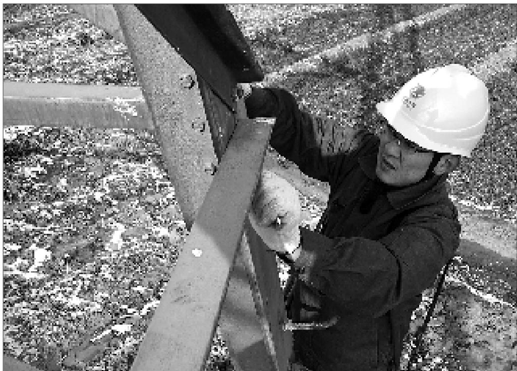
14日,济宁气温骤降,为了确保输电线路安全稳定运行,济宁供电公司输电工区加强了线路巡视力度。图为该公司输电工区线路运行人员在220千伏罗宿线巡视。 本报记者 刘守善 本报通讯员 魏司法 摄
