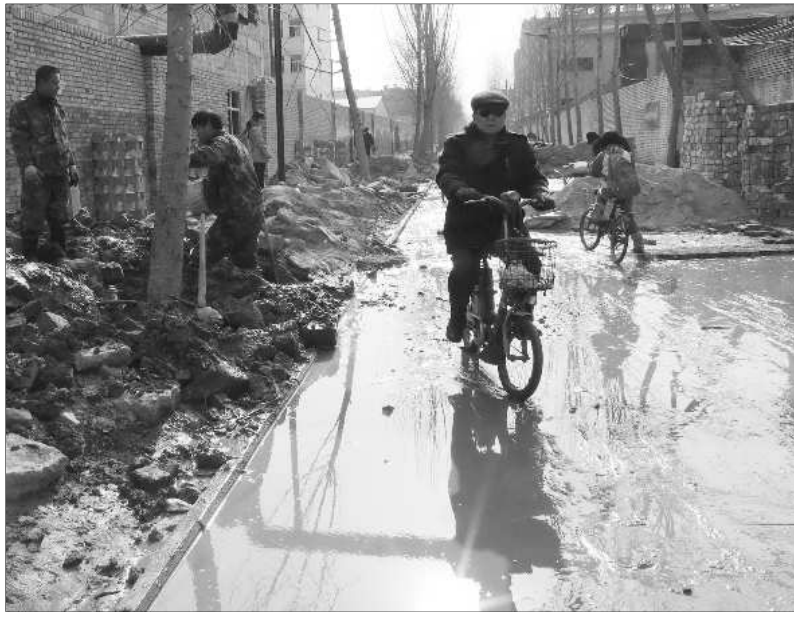
维修人员正在抢修漏水管道,一位老先生在满是泥浆的路上通过。 见习记者李璇 摄
