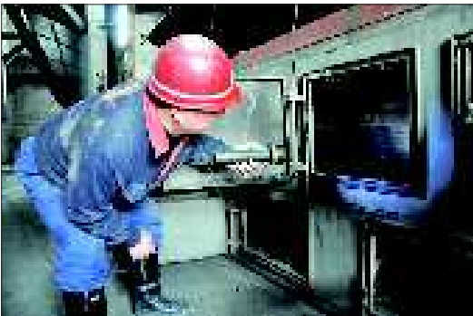
华阳热电1号站,维修人员正在检查锅炉。 本报记者 赵金阳 摄
