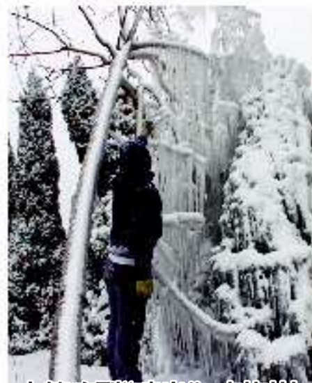
水管冻裂“喷出”一树树挂
