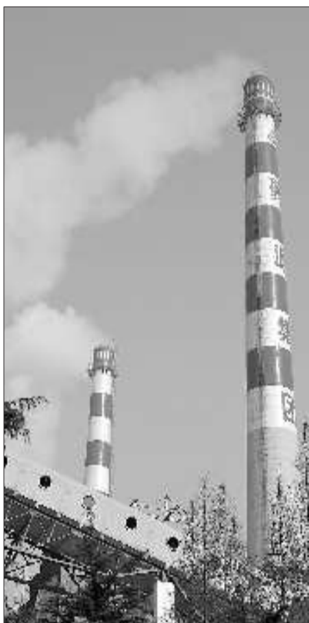
东郊热电厂两大烟囱排出的白色烟雾为水蒸气 本报记者 刘守善 摄
