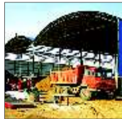
正在建设的高新区梁场。
