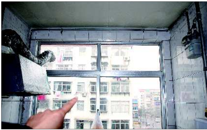
邻居家的天然气管道足足比纪女士家的管道长了3米左右。
