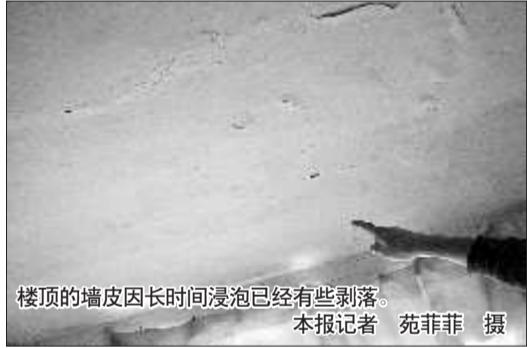
楼顶的墙皮因长时间浸泡已经有些剥落。
