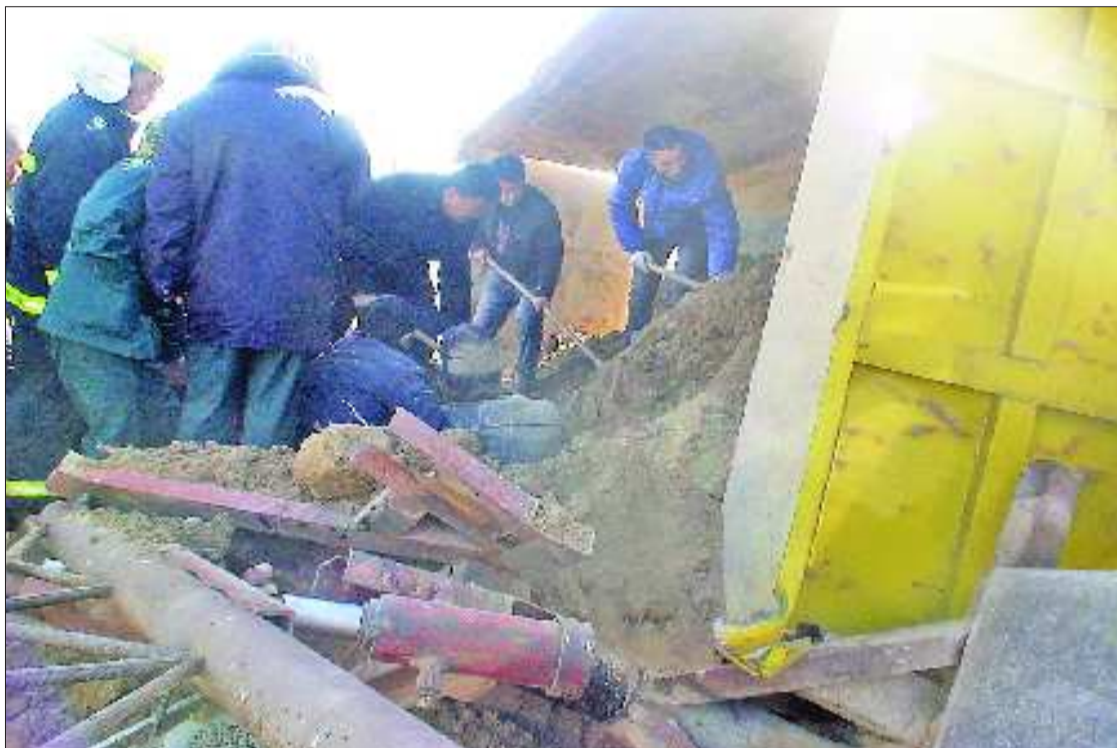
消防官兵和群众正奋力挖土营救被埋在土里的驾驶员。 本报通讯员 王海华 摄
