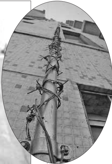
居民在管道上缠绕了铁疾黎。为了防正盗贼攀爬管道,
