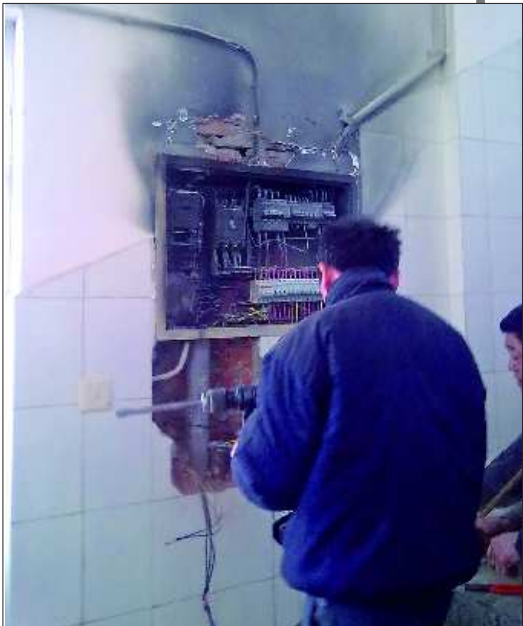
工作人员在维修电表。
