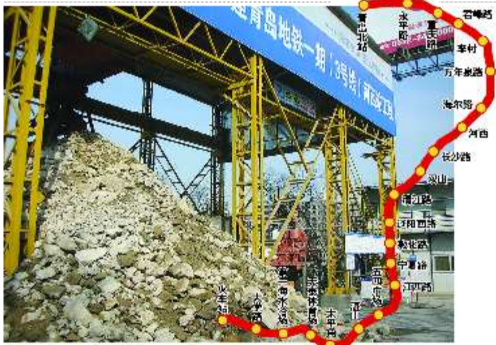
保河区间竖井施工挖出的土石堆成小山。 宋珊珊 摄
