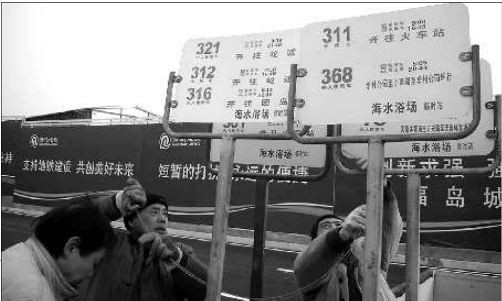
► 汇泉广场占用草坪修起调流道,工人正在安装站牌。 本报记者 宋珊珊 摄
