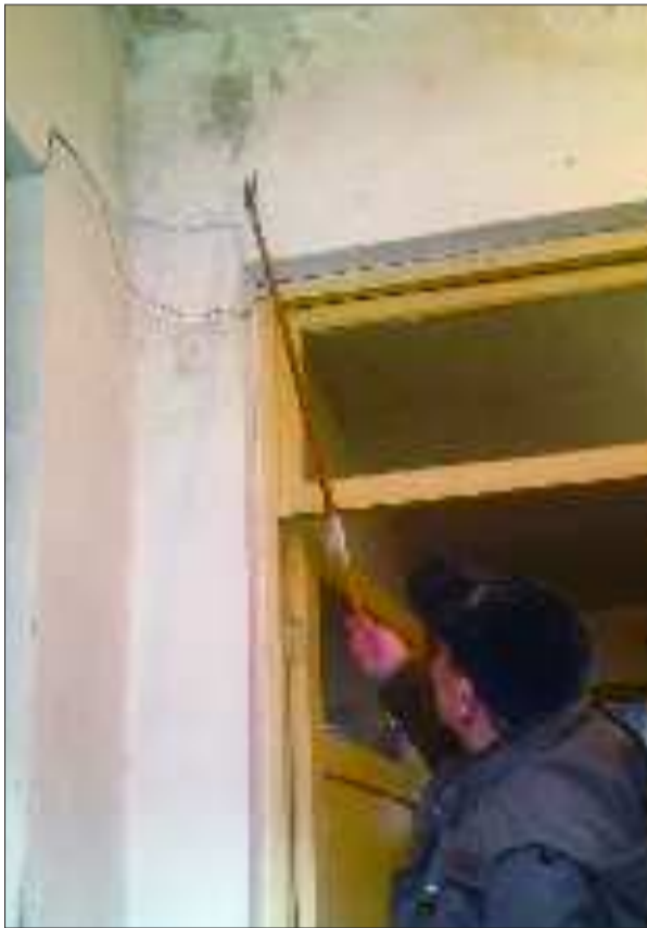
张先生家房顶的漏水点墙皮脱落严重。 见习记者 刘德峰 摄
