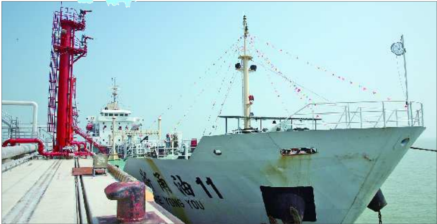
正在作业中的东营港3万吨级液体化工码头。(资料片)
