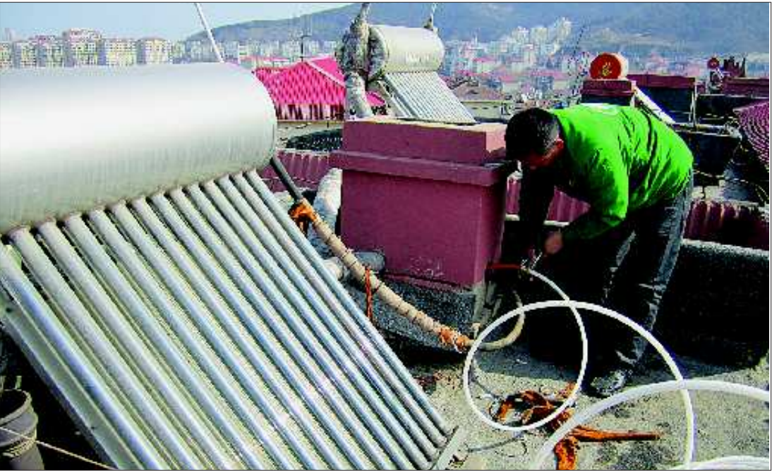
皇明太阳能维修人员正在为居民家的太阳能重新安装管线。本报见习记者 孙芳芳摄
