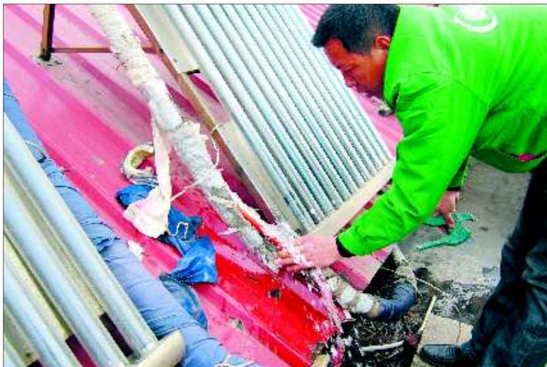
维修人员发现,这款杂牌机器的管子冻裂了。 本报见习记者 牟晓梅摄
