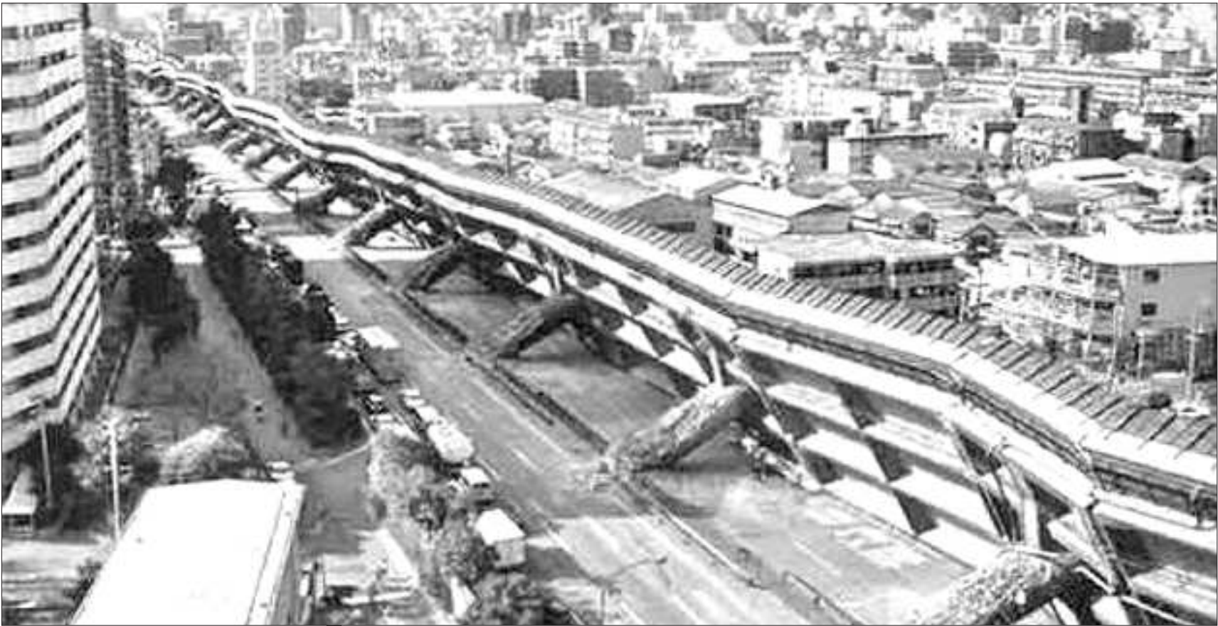
▲1995年,日本神户大地震后倒塌的高架桥。(资料片)
