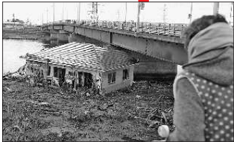
12日,日本宫城县仙台市,一幢民居被海啸卷起的巨浪冲到一座桥下。
