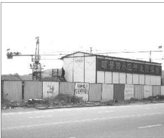
网上开卖的颐景园小区并未开盘,还在建设当中。
