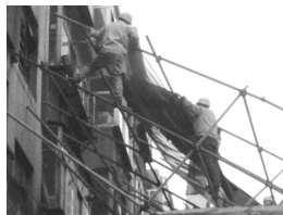
拆除倾倒的脚手架上的防护网 本报记者 赵兴起
