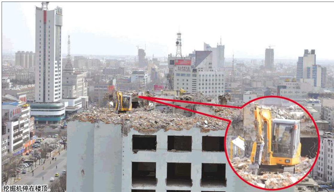
挖掘机停在楼顶。
