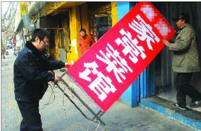
15日,执法人员对影响居民休息的灯箱进行了拆除。 见习记者 陈伟 摄
