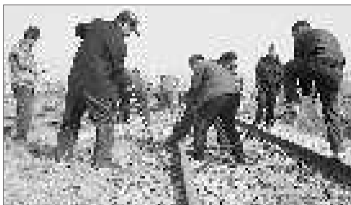
施工人员正在紧张施工 吴慧 摄
