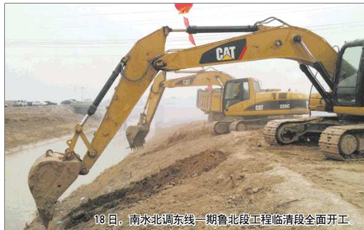
18日,南水北调东线一期鲁北段工程临清段全面开工。
