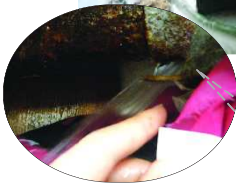
自来水从水管破裂处就这样“哗哗”流了一个多月。 本报记者 苑菲菲 摄
