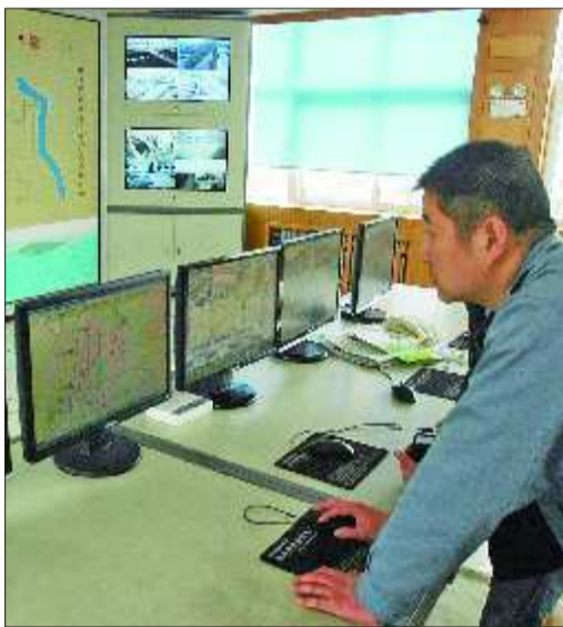
水厂各个环节的运行在监控室内一览无余,图为工作人员正在监控。 本报记者 马志勇摄
