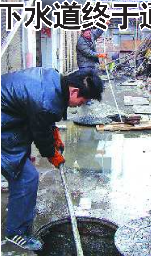
盐业公司物业人员疏通下水道。
