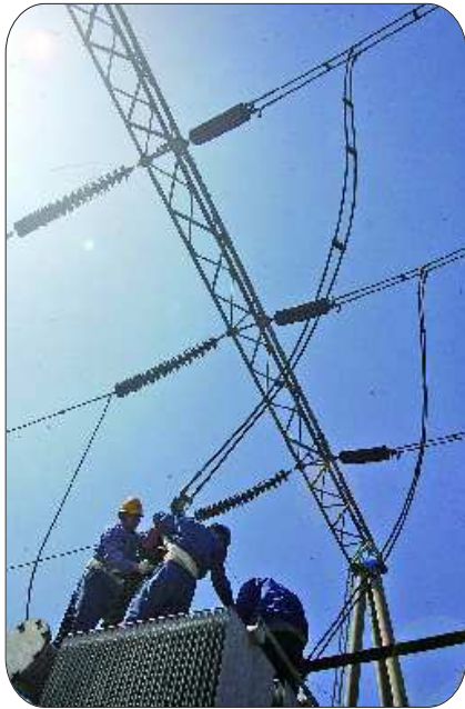
三名工作人员正在参与检修。
