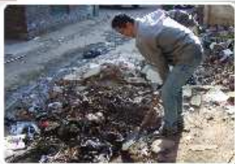
王清彬在清理污水管道。
