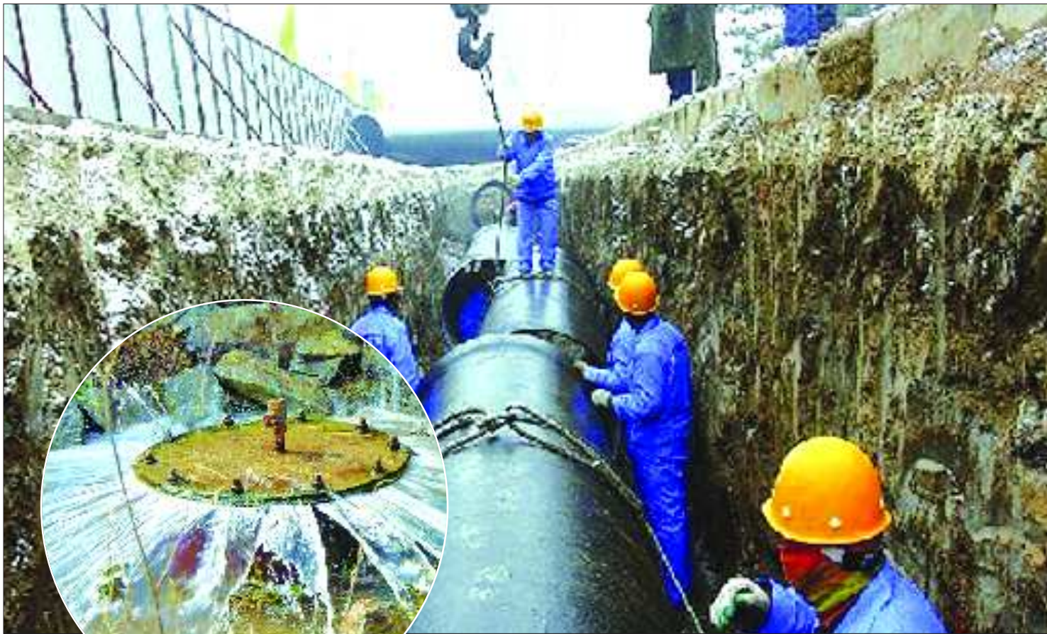
▲济西二期引水工程正在加紧施工。(资料片) ◆济西地下水很丰富。
