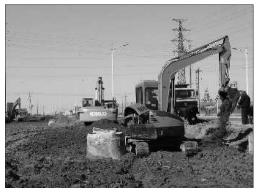
福州路施工现场,挖掘机正在进行基槽整理和碱土调运施工。 本报见习记者 任小杰 摄
