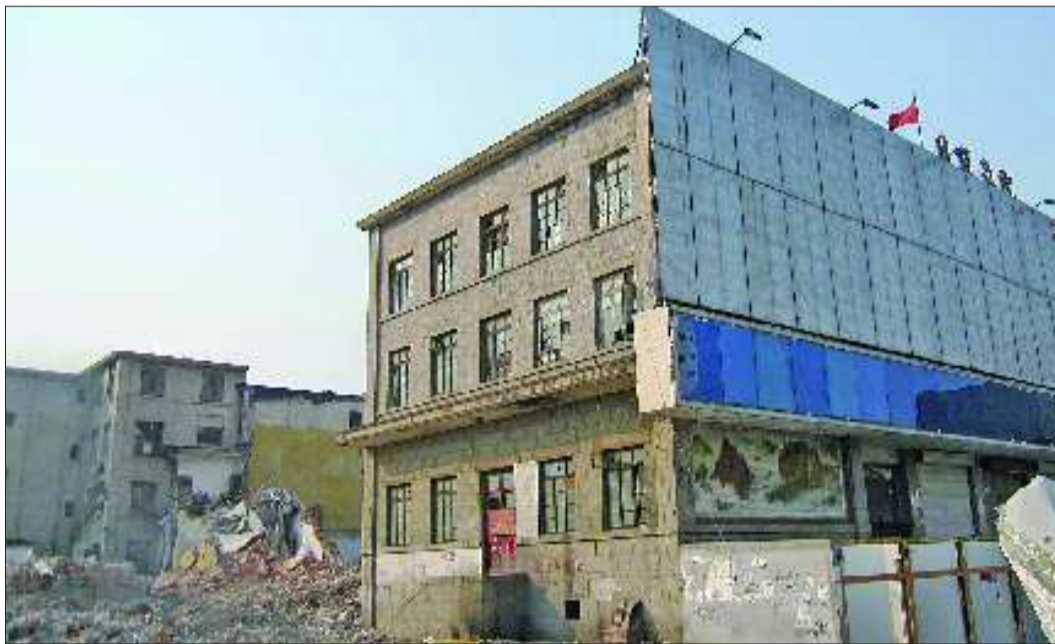
30日,副楼和放映厅已经拆迁完毕,只剩下了主楼。 本报记者 侯健 摄
